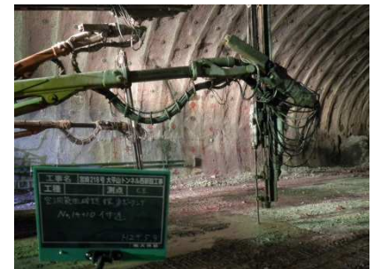
写真-3 穿孔探査状況
