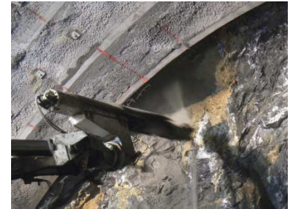
写真-2 空洞充填状況
