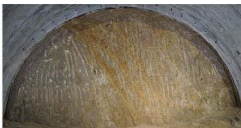
図-5 切羽のRGB反射強度画像
