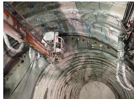
写真 1 側壁導坑拡幅掘削長尺先受状況
