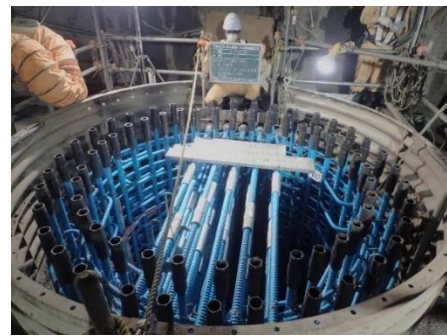
写真2 鉄筋組立完了状況(R4)
