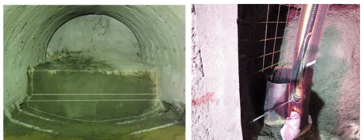
図-1 対策工の施工状況
