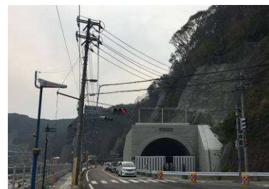
写真 3 完成した坑門
