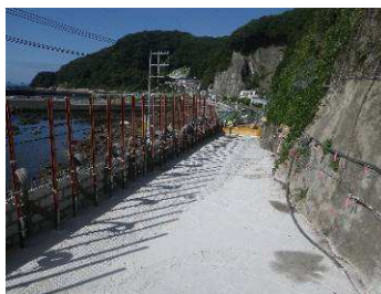
写真 2 エアモル打設状況
