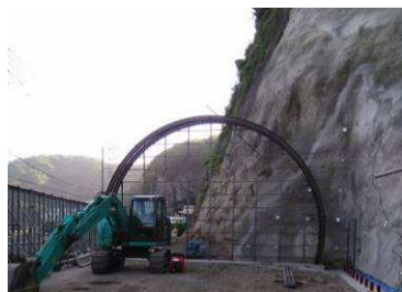
写真 1 突出型坑門 支保工
