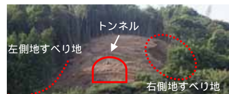
写真-3 起点側坑口部 全景
