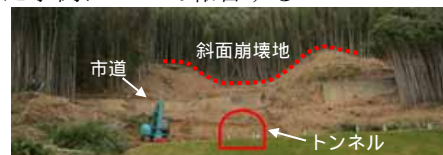
写真-1 終点側坑口部 全景
