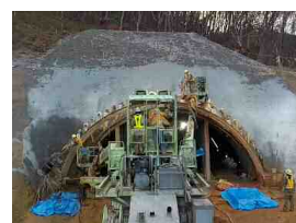
写真-5 LL-Fp 削孔状況
