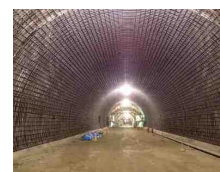
写真-10 鉄筋組立完了
