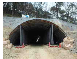
写真-3 坑内支柱設置
