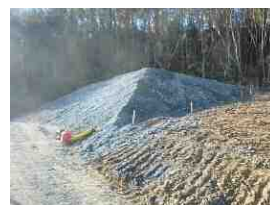
写真-4 押え盛土
