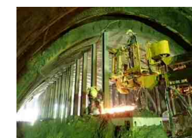
写真-8 坑内支柱撤去状況
