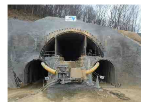
写真-6 側壁導坑掘削完了
