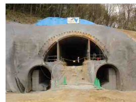
写真-7 側壁コンクリート完了
