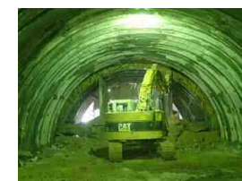
写真-9 再掘削状況
