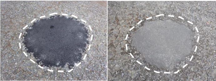
写真－1 施工完了
