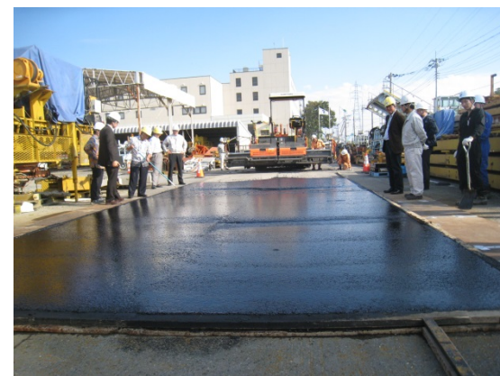
写真-3 産地 B の AsButon を用いた試験施工
