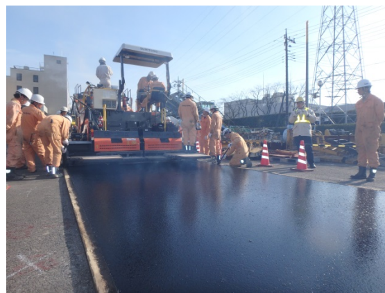
写真-2 産地 A の AsButon を用いた試験施工
