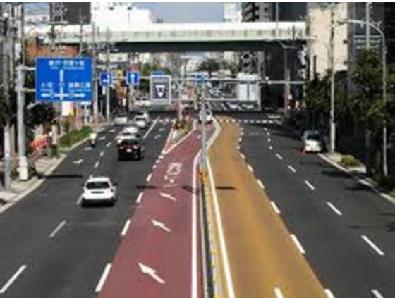
写真－1 着色された右左折レーン
