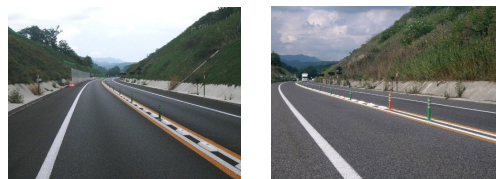
写真-2 施工箇所の供用状況
