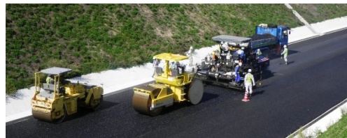
写真-1 施工状況
