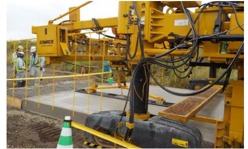
写真-1 施工状況
