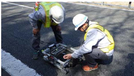
写真-3 透水性試験状況
