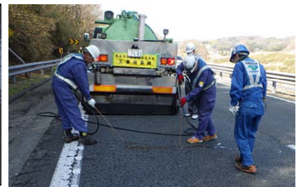
写真-5 クラックシール状況
