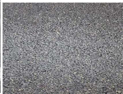
写真－3 中温化技術区間路面接写
