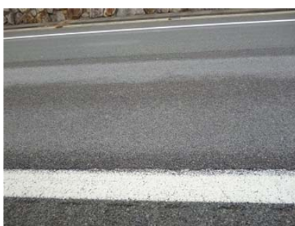
写真－5 在来工法区間路面状態
