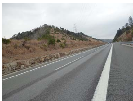
写真－4 在来工法区間全景
