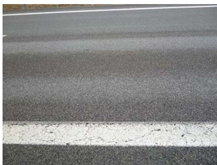
写真－2 中温化技術区間路面状態
