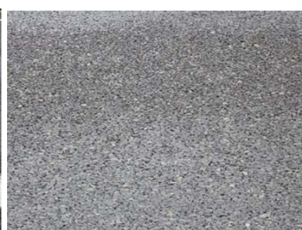
写真－6 在来工法区間路面接写
