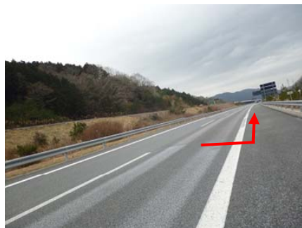
写真－1 中温化技術区間全景
