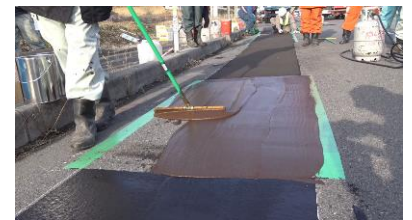
写真-2 試験施工実施状況
