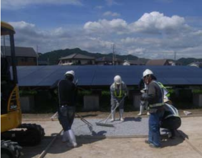
写真-4 砕石敷ならし状況
