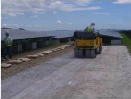
写真-3 転圧状況
