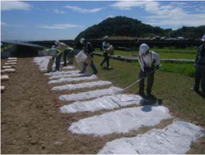
写真-1 固化材敷ならし状況
