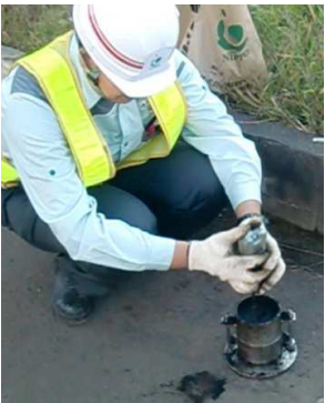
写真-2 貫入抵抗試験
