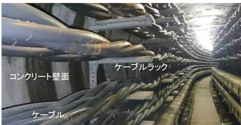
写真-1 電力用トンネルの様子
