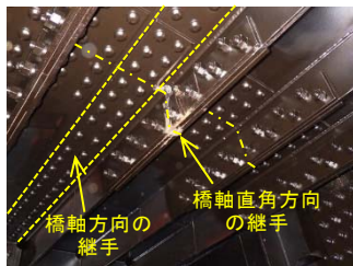
写真 3.1 継手部の漏水腐食 写真 3.2 腐食部拡大
