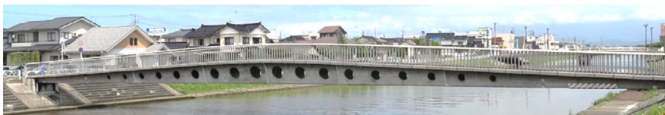
写真 1 酒田みらい橋の全景写真
