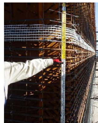
写真4 ガラス繊維ネット設置状況
