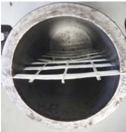
写真1 ガラス繊維 ネット設置状況
