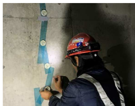
注入座金を固定用テープで設置
