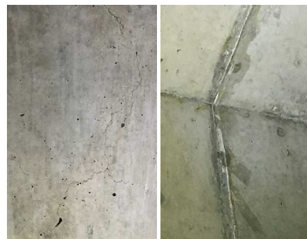
シールテープ 使用 撤去後外観
