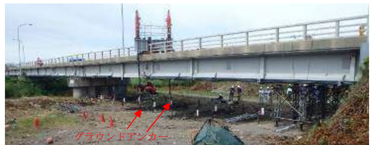
写真-1 載荷径間全景
