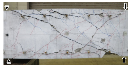
写真-2 実験終了後のひび割れ状況
