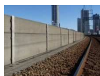
写真-1 高欄全景
