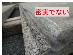
写真-8 下端内部
