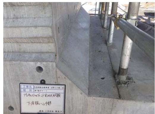
写真-2 脱型状況(下床版ハンチ部)
