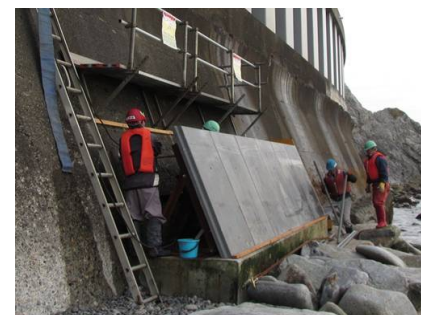
図 2 擁壁補修工事の状況
