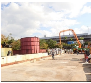
写真-2 打込みの状況
