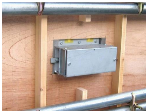
写真2 ボス型枠の構造体型枠への取付け
