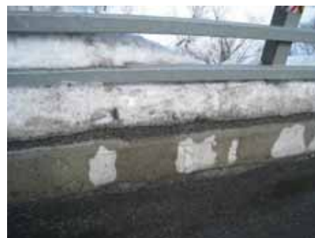
写真-2 冬期の地覆の様子の一例
