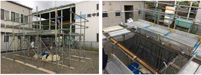
(a) 全体状況 (b) ネット設置状況
