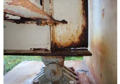
写真1 鋼橋桁端部の腐食状況
