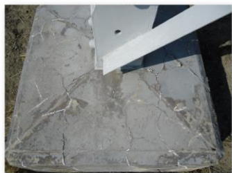
(a) 基礎体天端部
