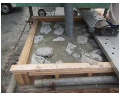
写真-1 モルタル注入状況
