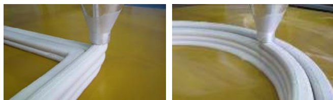
写真-4 安定した吐出量と積層状況
