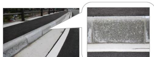
図1 1期工事のブロックの表層劣化の例
