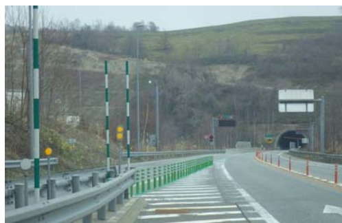
写真-1 逆走防止対策用ラバーポール設置状況
