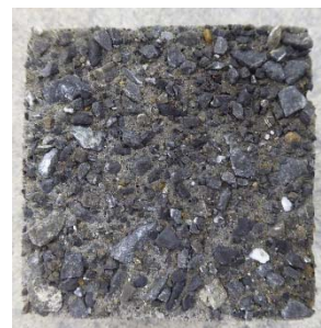
写真-2 粗面処理後の例
