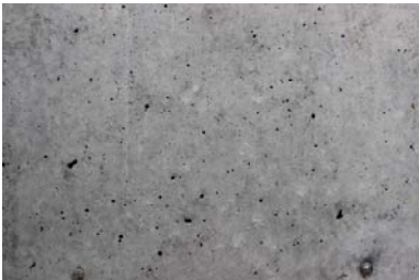
写真-1 天端近傍の表面気泡
