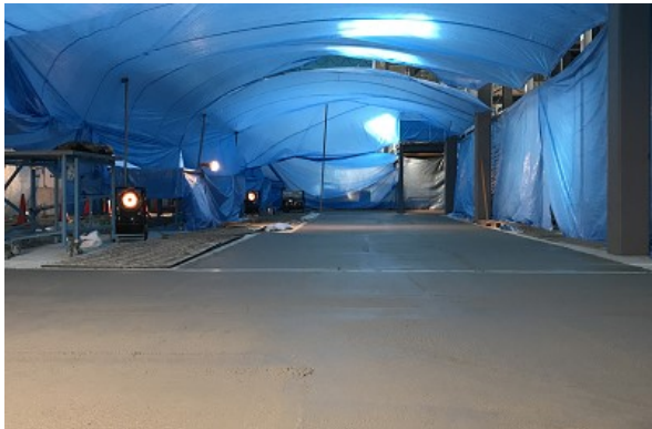
写真-2 施工完了および養生状況
