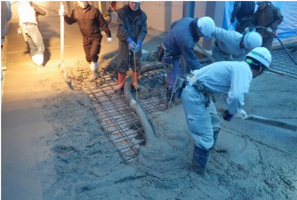
写真-1 打込みおよび締固め状況
