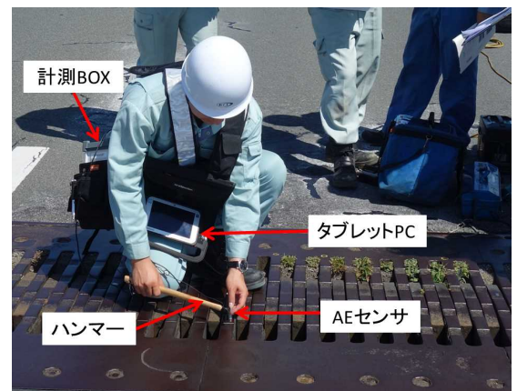
図 1 AE センサを用いた打音検査 外観
