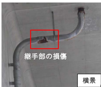
（写真-2 漏水による継手部からの腐食状況）
