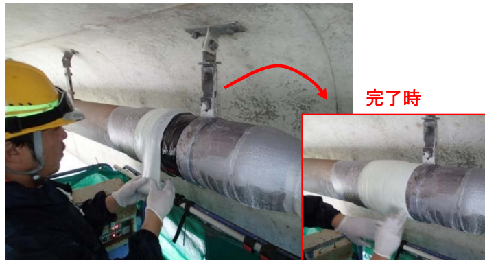
(写真-6 グラスファイバー製テープ施工状況)
