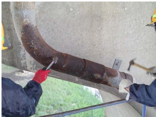
(写真-3 ケレン状況（錆の除去）)
