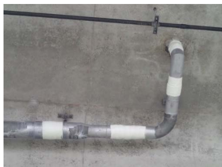
(写真-8 漏水箇所補修後)
