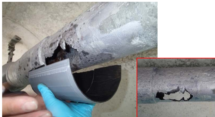
(写真-4 調整型枠材設置状況)
