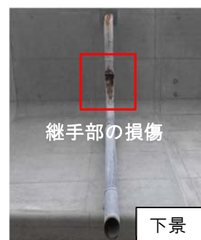
（写真-2 漏水による継手部からの腐食状況）
