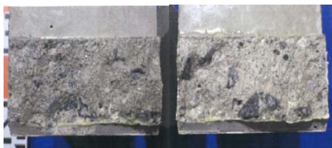
図-3 注入剤 A-① (初期ひび割れ 0.2 mm)
