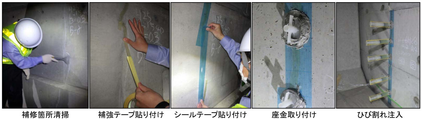
写真-1 施工の流れ
