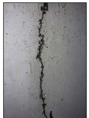
写真-4 テープ撤去後
