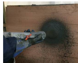
写真-1 吹付け状況
