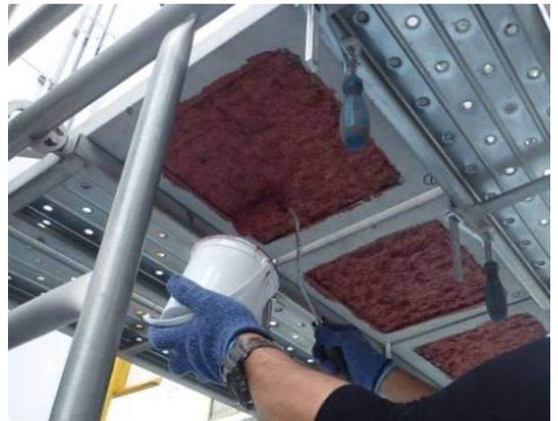
写真2 はく落防止層施工状況
