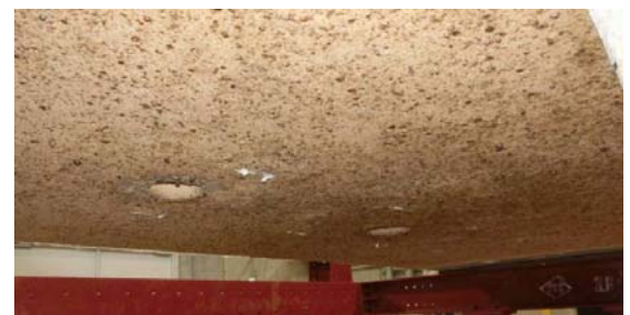
写真 4 加熱面拡大 (本体部試験体)
