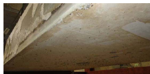
写真 4 加熱面拡大(本体部試験体)
