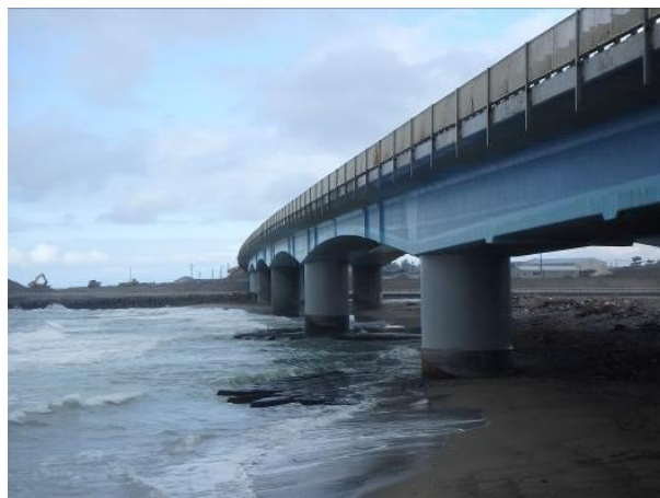
写真-1 海岸部に架設された橋梁
