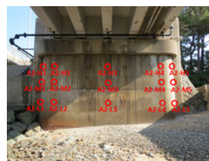
写真-4 A2 橋台設置位置
